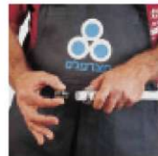
3 Założenie nakrętki i wsunięcie złączki
